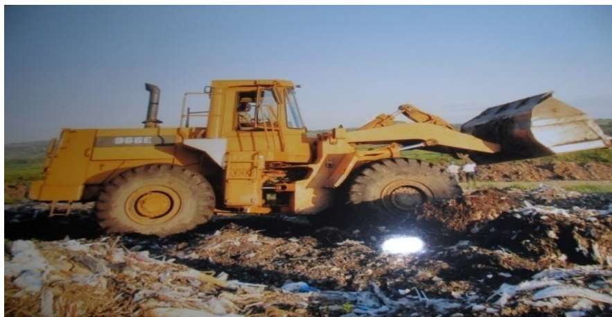
Mtambo wa kukodi wa wheel loader ukiwa kazini
