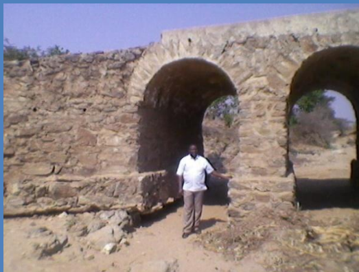
Mchoro 4.1: Daraja la mawe mfano wa upinde kuonesha kuta na uwekaji wa jiwe kuu. Mchoro 4.2: uwekaji wa Jiwe kuu la kati ili kulipa daraja uhimili unaotakiwa.
